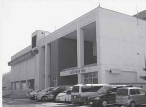
大規模改修を予定しているスポーツセンター
