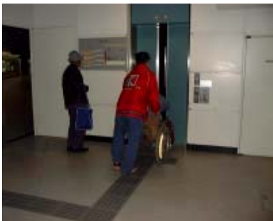
図 新千歳空港駅通路エレベーター
