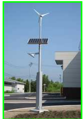
風力・太陽光発電LED外灯
